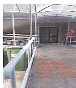
Ingresso Vano scala posteriore C
