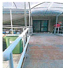
Ingresso Vano scala posteriore C
