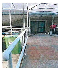
Ingresso Vano scala posteriore C
