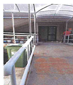
Ingresso Vano scala posteriore C
