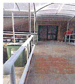
Ingresso Vano scala posteriore C
