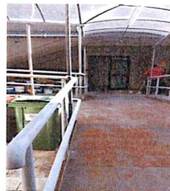
Ingresso Vano scala posteriore C
