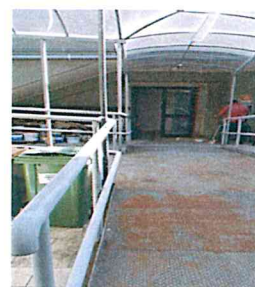
Ingresso Vano scala posteriore C
